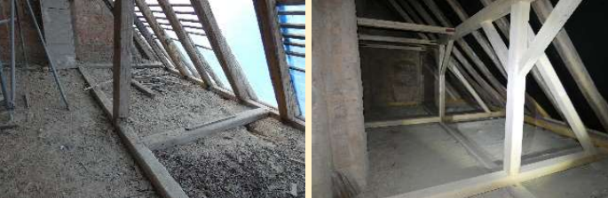
Dachkonstruktion Schleppdach vor der Sanierung (links) und danach (Fotos: Ingenieurbüro Eichhorn, Gera)
