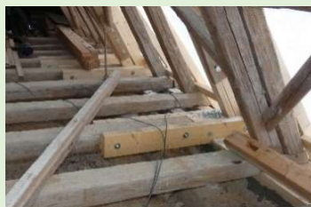
Beispiel für Schäden an der Dachkonstruktion, vor der Sanierung und danach
